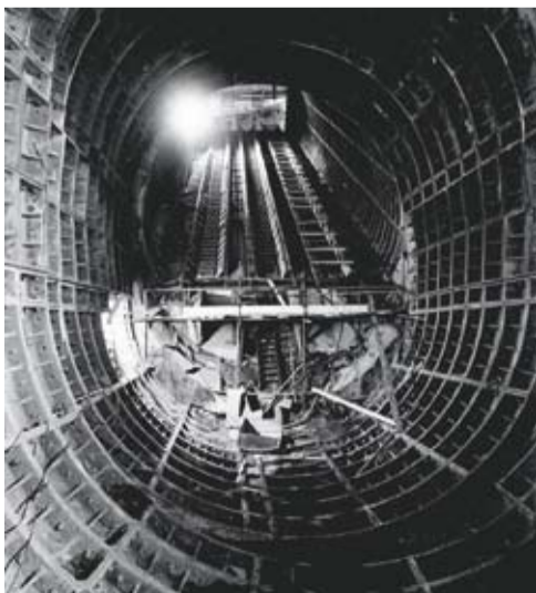
Napínací komora eskalátorů ve stanici Florenc
