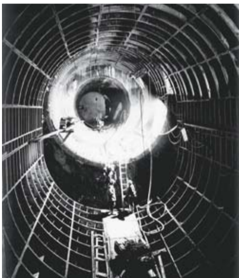
Přestupní uzel AB – nejvyšší dočasná kaverna na metru
