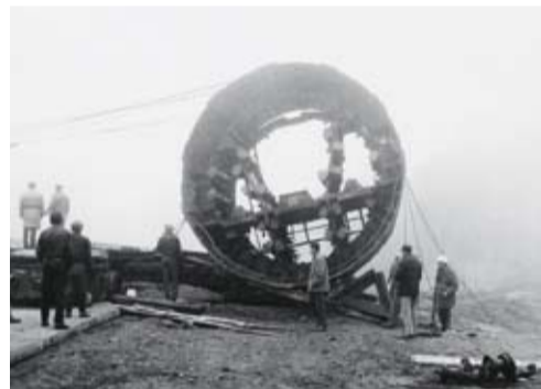
Nemechanizovaný štít ŠČN-1 pracoval na tunelech trasy I.C mezi Štětkovou ulicí a náměstím Hrdinů
