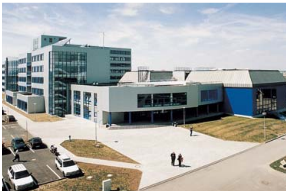
Komplex budov pro Elektrotechnickou fakultu ZČU v Plzni je skutečně dobrou vizitkou divize 1.
