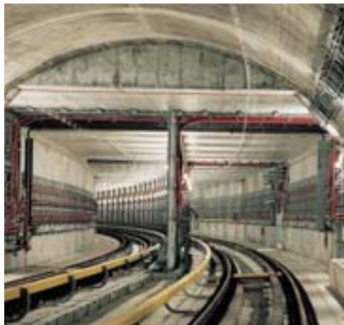
Kolejový svršek i betony trasy IV. C1 realizovala divize 3.
